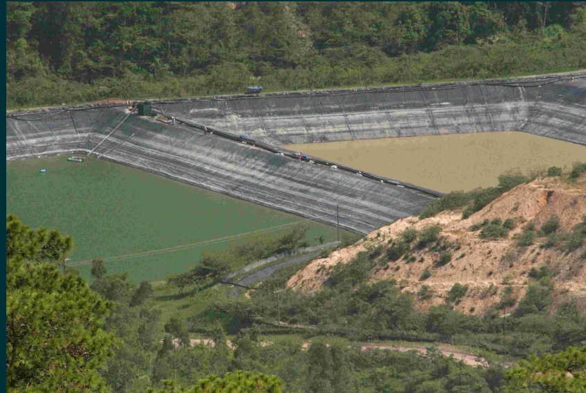
Dique de cola de la mina San Andrés, Copán, Honduras.
